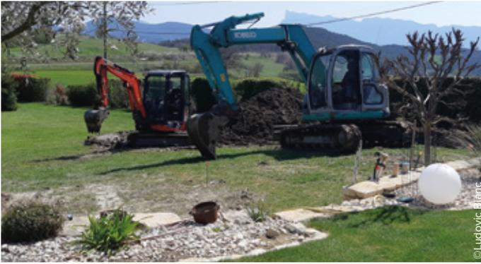
Afin de réaliser ce chantier, une pelle de 8 tonnes a été nécessaire pour l'excavation des terres de la piscine, une pelle 2,6 tonnes pour la manutention et les fouilles, ainsi qu'un poids lourd.
