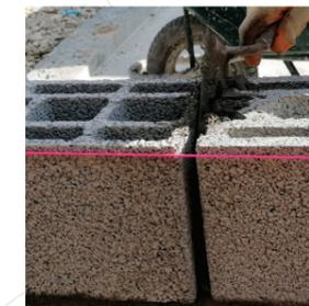
Rebouchage mortier 3 mm à 50 mm
