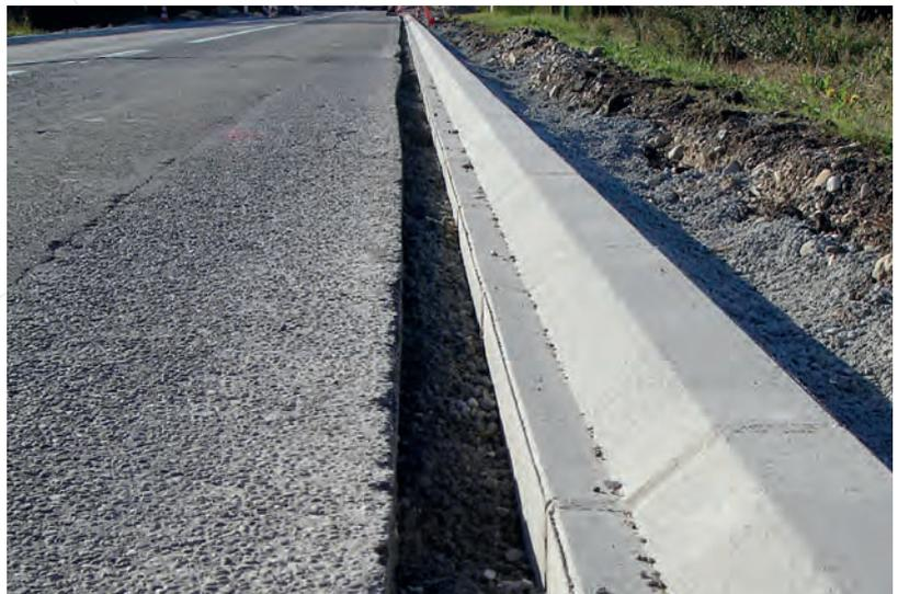
**INFOS** Le mortier joint doit être dosé à 200kg/m, ne jamais exéder 250 kg/m<sup>3</sup> avec un espace vide de 0,5 cm tous les 10 m
