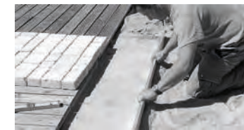
Égaliser le lit de pose à l'aide d'une règle.
