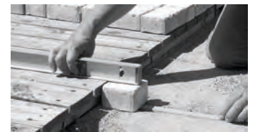
Vérifier la parfaite planéité du support lors de la pose des premiers pavés.
