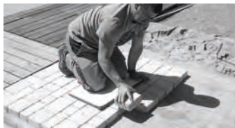
Déplacez-vous à l'aide d'une planche sur les pavés déjà posés.
