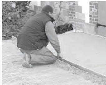
Égalisation de la couche de sable à l'aide de cales de niveau.
