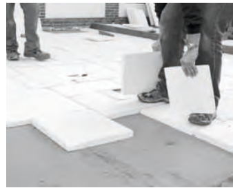
Mise en place des dallages (ici des dalles Castellane pack multiformat) sur lit de sable parfaitement de niveau.
